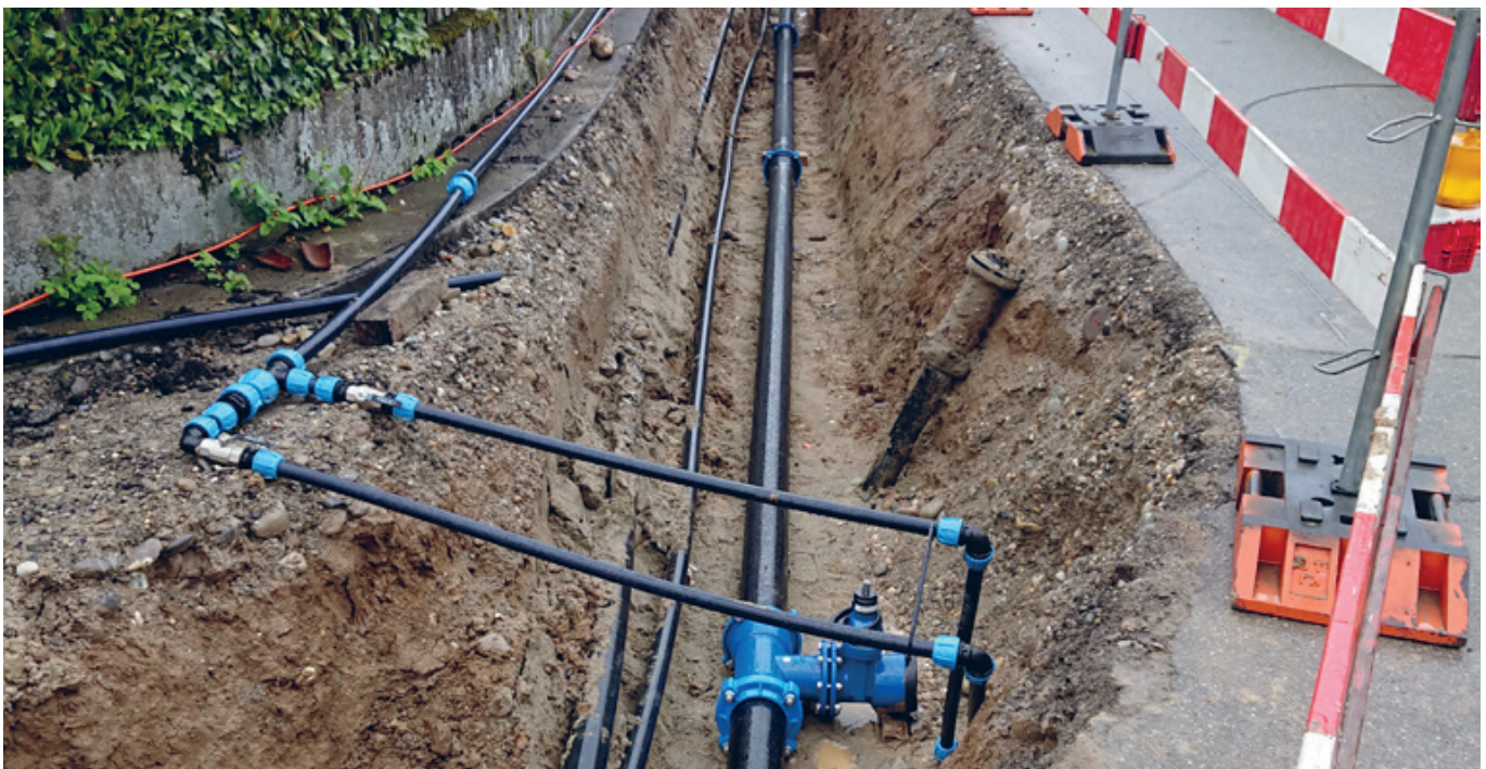
Bau der neuen Trinkwasserleitung untere Längmatt
