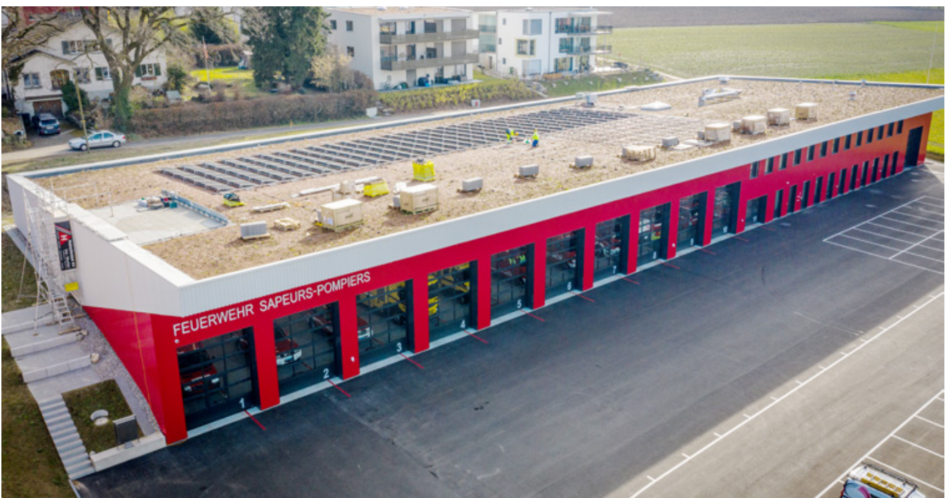
Bau der neuen Photovoltaik-Anlage auf dem Feuerwehrzentrum
