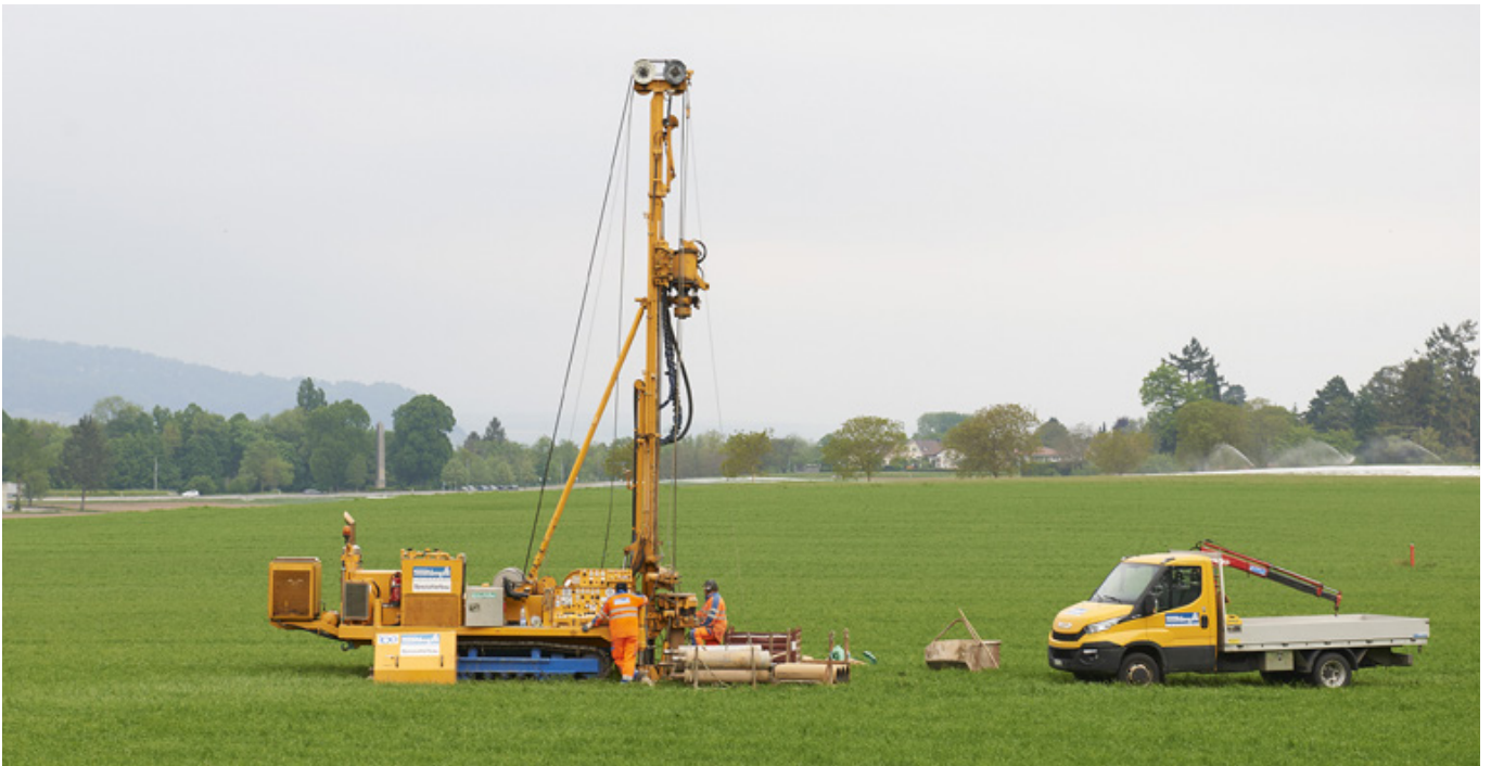
Probebohrungen auf der Suche nach neuem Trinkwasservorkommen
