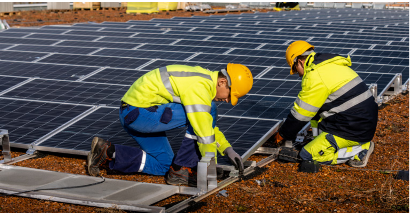
Montage von Solarpannels auf dem Dach des Feuerwehrzentrums
