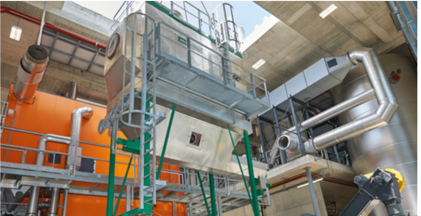
Der bestehende grosse Elektrofilter wird, durch die Decke gehoben, zum kleineren Ofen umplatziert
