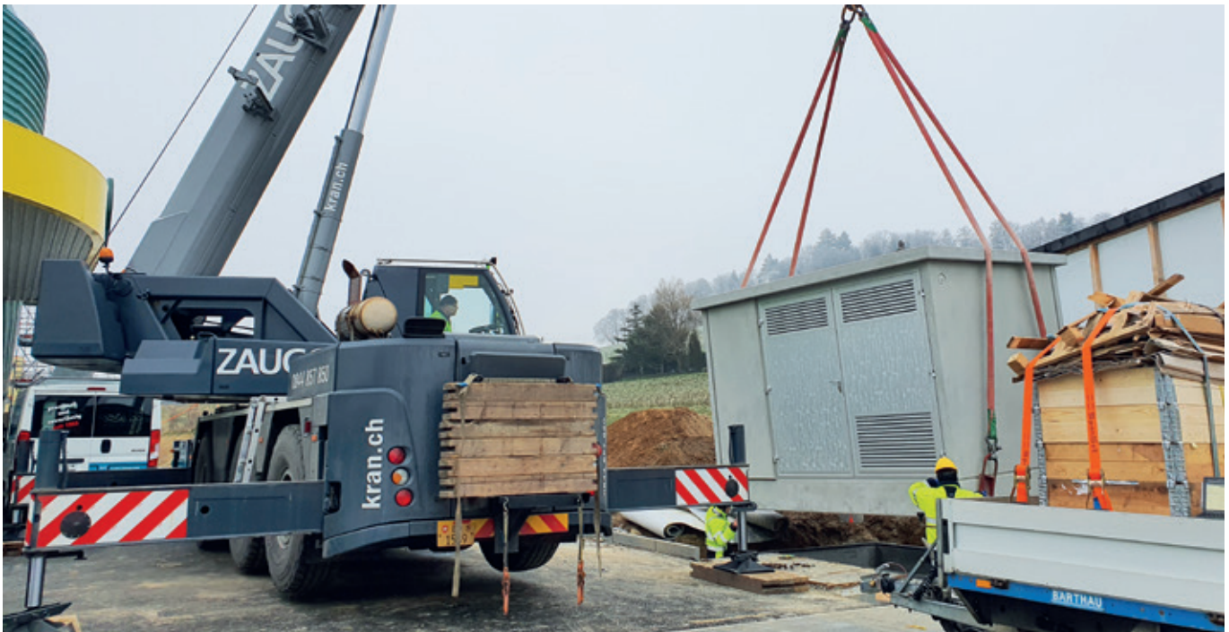
Bau der neuen Transformatorstation Landi
