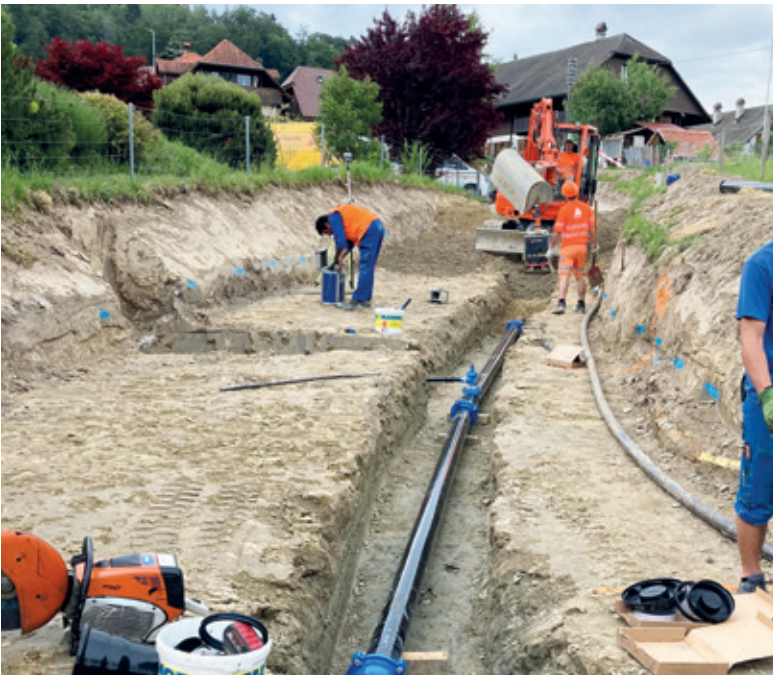
Bau der neuen Trinkwasserleitung Schabelrain in Courlevon
