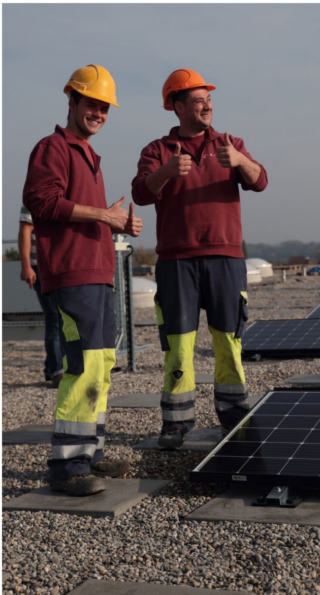
Erfolgreiche Montage der PV-Anlage Längmatt 6.
