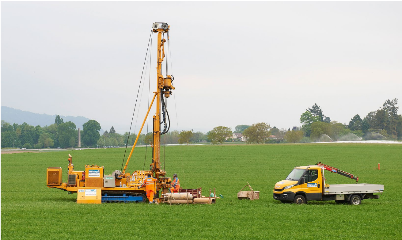
Bohrungen auf der Suche nach einem Ersatzstandort für die Grundwasserfassung.
