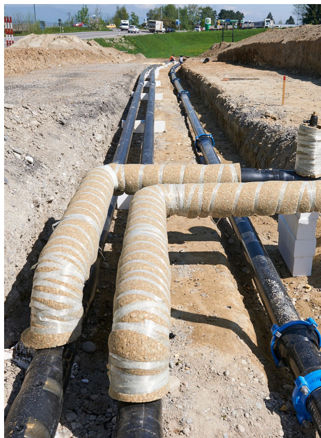
Neue Wasser- (rechts) und Fernwärmeleitungen (links) am Herrenschwandweg.
