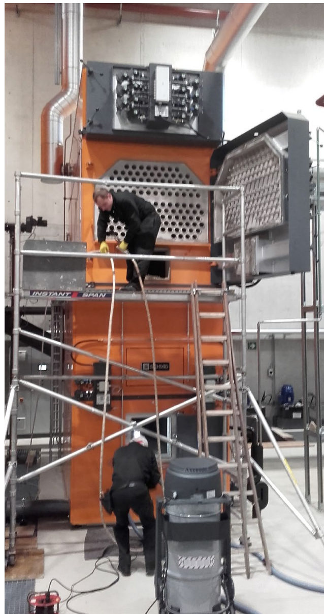
Unterhaltsarbeiten am kleineren Holzheizkessel.
