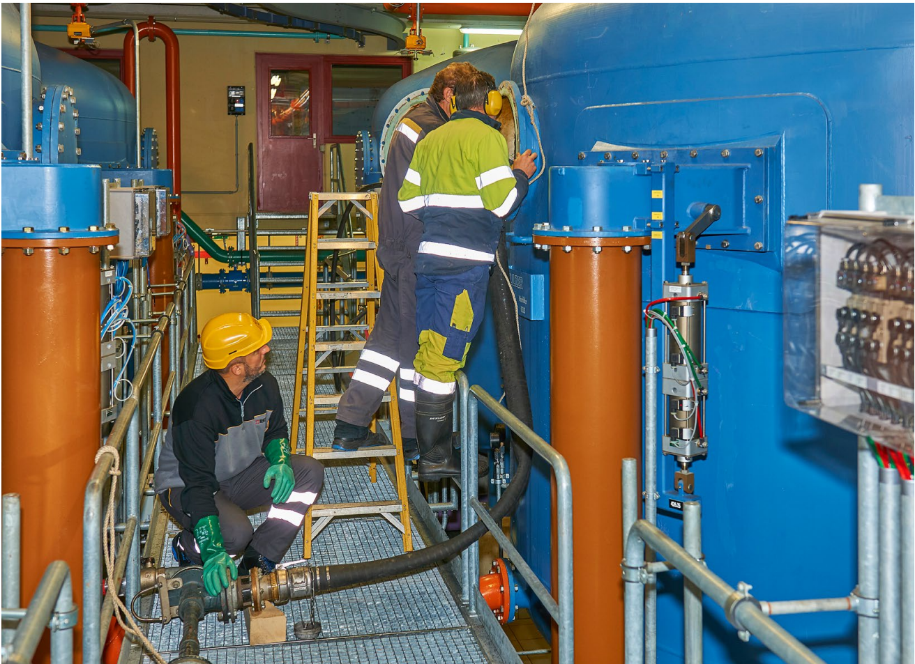
Austausch der Aktivkohle im Seewasserwerk.
