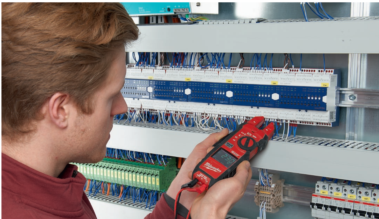
Lernender Jan Winkelmann (4. Lehrjahr) überprüft die Spannung
