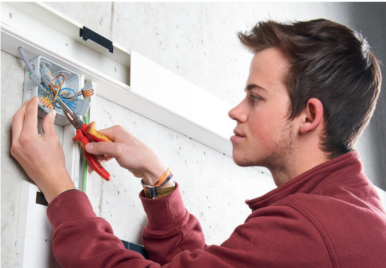
Lernender Colin Schmid (3. Lehrjahr) verdrahtet eine Abzweigdose.
